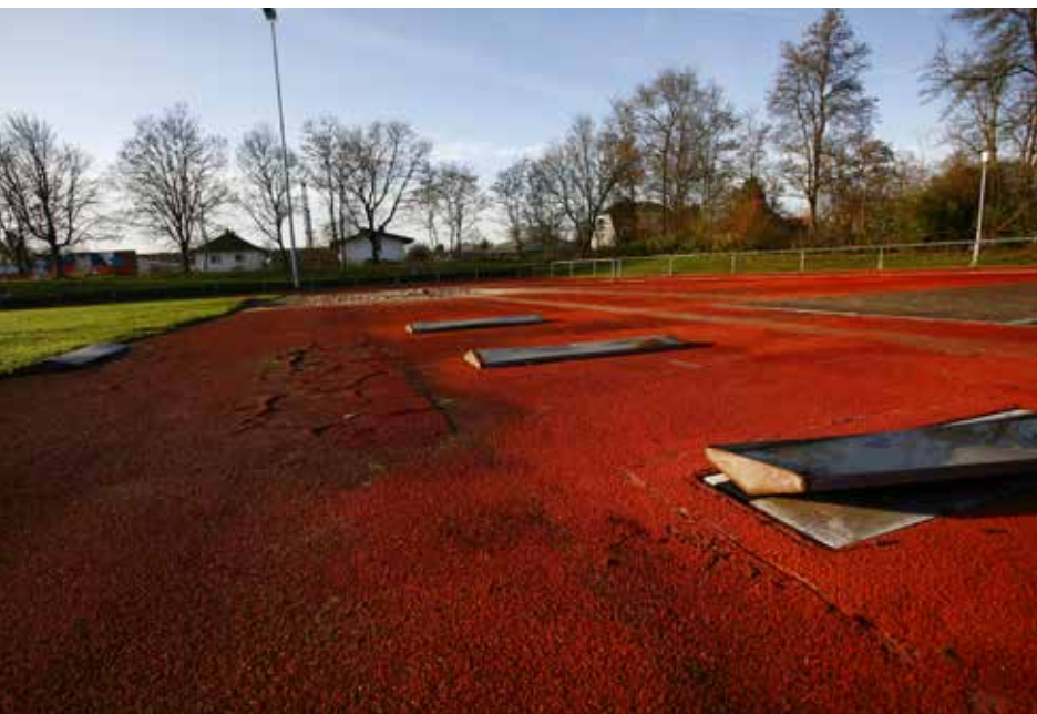
Der Anlaufbereich und die Weitsprunggrube haben die beste Zeit hinter sich, eine Sanierung ist unumgänglich.
