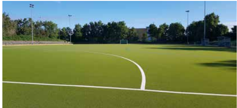
Der Hockey-Kunstrasen erstrahlt nach der Sanierung in neuem Glanz.
