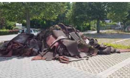
Teile der abgetragenen Laufbahn, die noch aus dem Jahr 1985 stammt.
