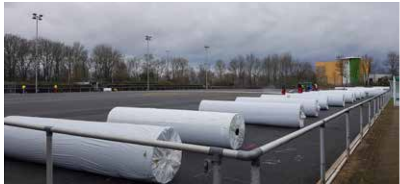
Kurz vor der Vollendung. Der neue Kunstrasenbelag wurde angeliefert und verlegt.
