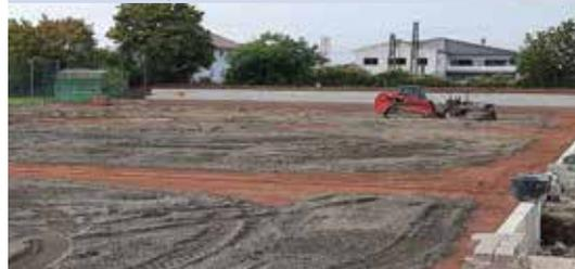
Die Untergrund-Arbeiten sind abgeschlossen, die Ziegelmehl-Schicht wird aufgetragen.
